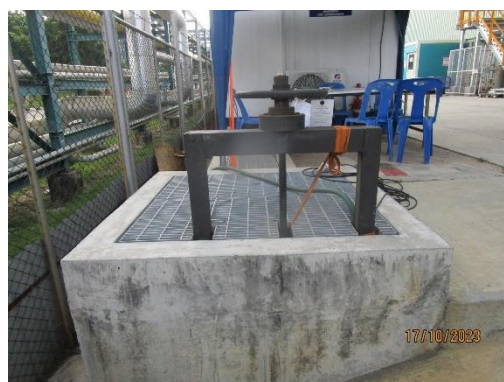
รูปที่ 27 บ่อตรวจสอบคุณภาพน้ำ (Inspection Pit) บริเวณรางระบายน้ำ
