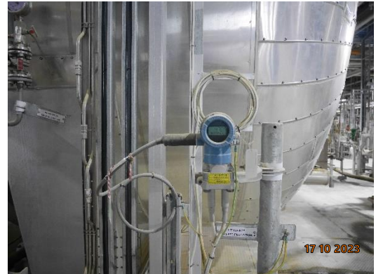
รูปที่ 62 ระบบวัดอุณหภูมิและความดันภายในถังปฏิกิริยาโพลีโอลชนิด PPG (PPG Reactor)
