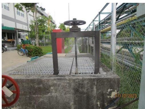
รูปที่ 27 บ่อตรวจสอบคุณภาพน้ำ (Inspection Pit) บริเวณรางระบายน้ำ
