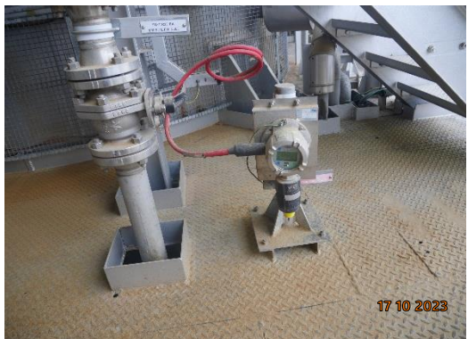
รูปที่ 58 อุปกรณ์วัดระดับ (Level Indicator) ของสารเคมีในถังเก็บ และสัญญาณเตือน (Level Alarm)
