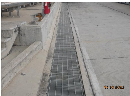
รูปที่ 25 รางระบายน้ำฝน และรางระบายน้ำเสีย
