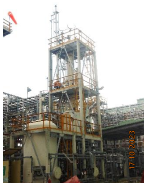
รูปที่ 6 ระบบบำบัดสารอินทรีย์ระเหยแบบเปียก (VOCs Wet Scrubber)
