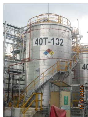
รูปที่ 3 ถังเก็บสไตรีน
