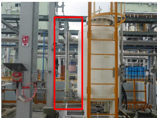
รูปที่ 58 อุปกรณ์วัดระดับ (Level Indicator) ของสารเคมีในถังเก็บ และสัญญาณเตือน (Level Alarm)
