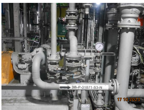
รูปที่ 60 ระบบ Isolate Valve บริเวณอุปกรณ์สูบน้ำ
