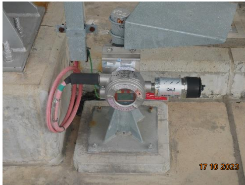
รูปที่ 61 อุปกรณ์ตรวจจับก๊าซ (Gas Detector)
