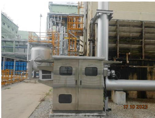
รูปที่ 22 อุปกรณ์ตรวจวัดคุณภาพน้ำเสียอัตโนมัติ ในบริเวณหอหล่อเย็น
