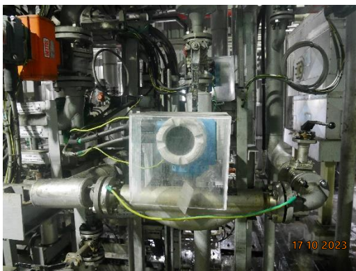
รูปที่ 63 ระบบวัดอุณหภูมิและความดันภายในถังปฏิกิริยาโพลีโอลชนิด POP (POP Reactor)
