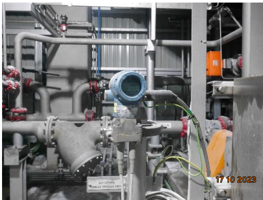
รูปที่ 62 ระบบวัดอุณหภูมิและความดันภายในถังปฏิกิริยาโพลีโอลชนิด PPG (PPG Reactor)
