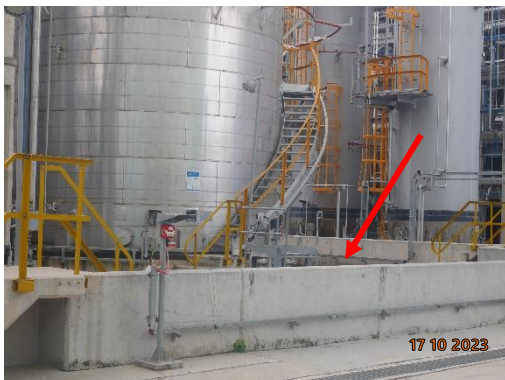
รูปที่ 54 คันกัน (Bund) ล้อมถังเก็บสารเคมี
