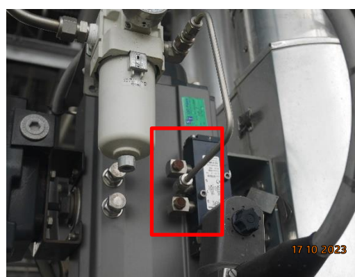
รูปที่ 11 การติดตั้งอุปกรณ์ลดเสียง
