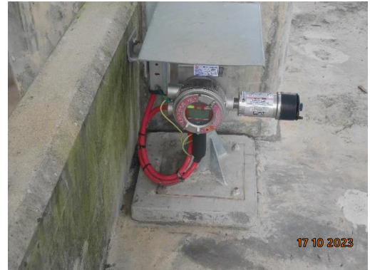
รูปที่ 49 Toxic Gas Detector บริเวณอุปกรณ์การผลิต ที่เกี่ยวข้องกับเอทิลีนออกไซด์
